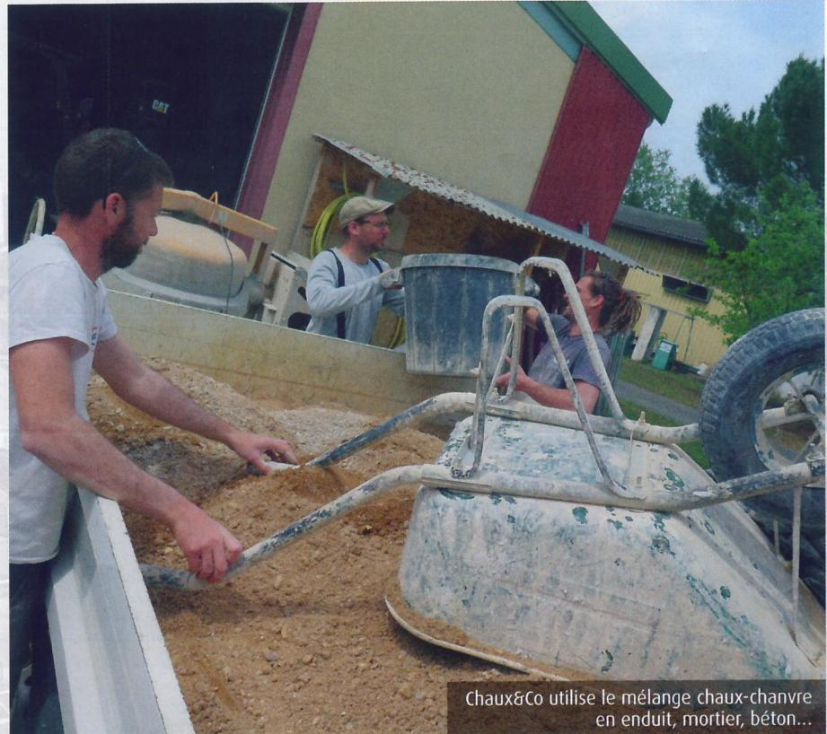
Chaux&Co utilise le mélange chaux-chambre en enduit, mortier, béton...
